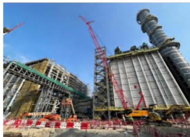
HRSG and Stack construction
