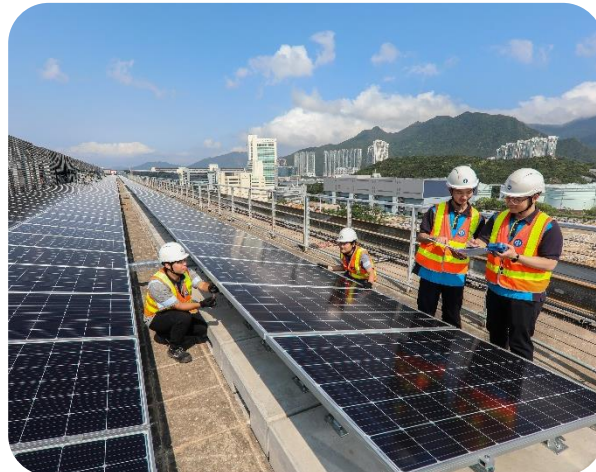
香港空運貨站有限公司安裝 中電源動的太陽能光伏板
