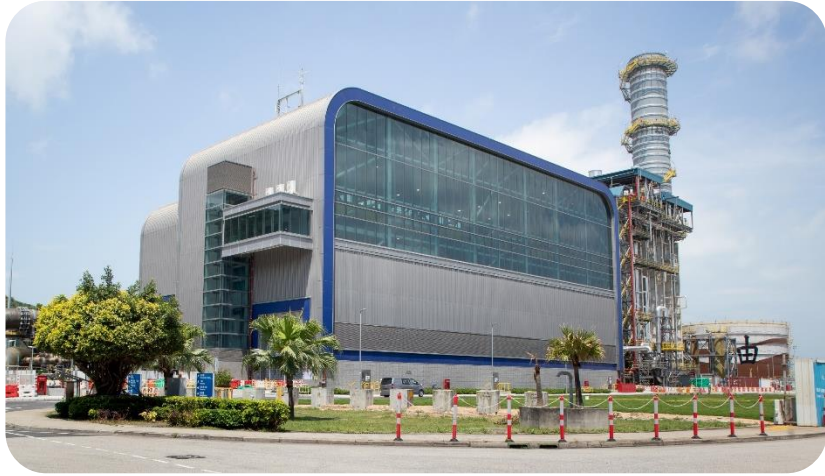
龍鼓灘發電廠首台新燃氣發電機組 投入運作，第二台工程進行中
