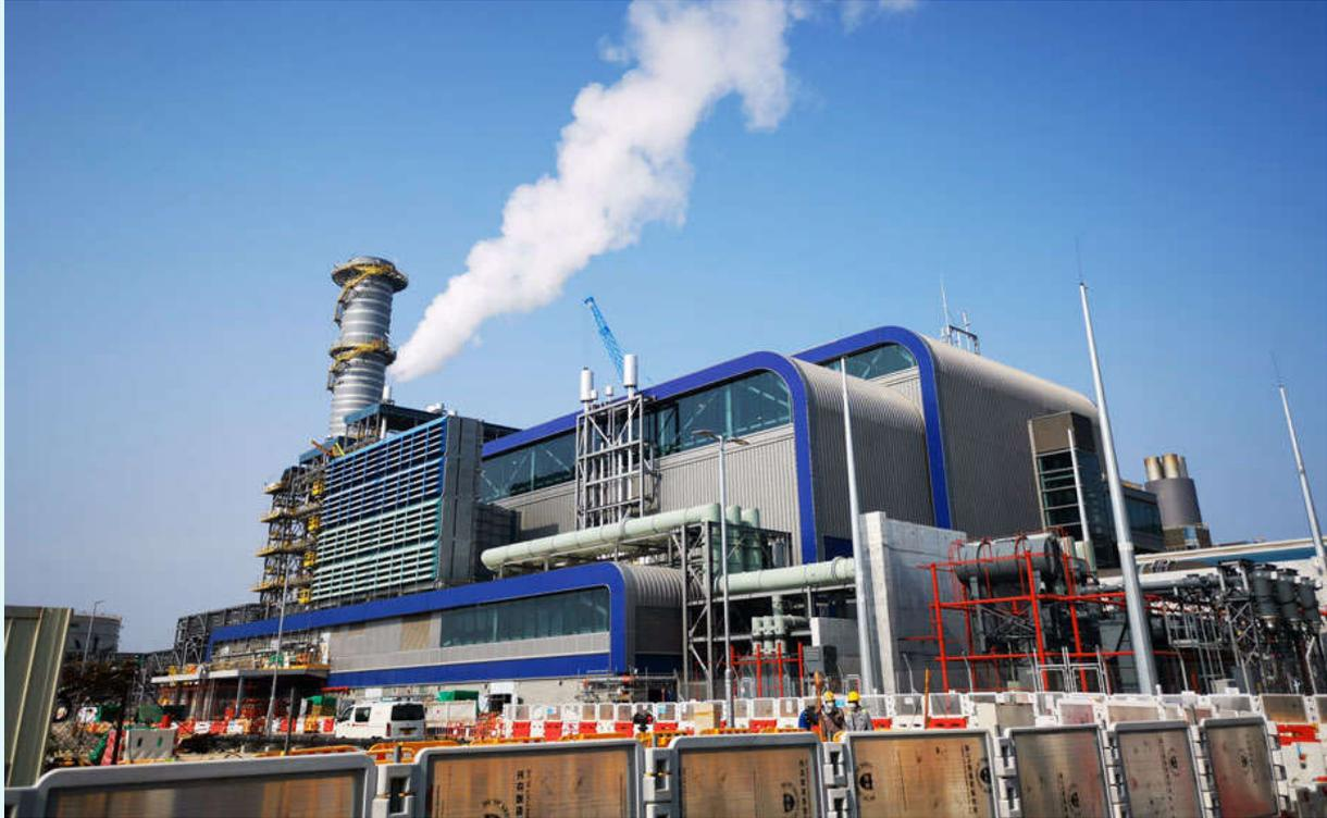
龍鼓灘發電廠一台 550 兆瓦的新建聯合循環燃氣渦輪機組預計於 2020 年投產。
