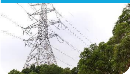
扩建现有基础设施
