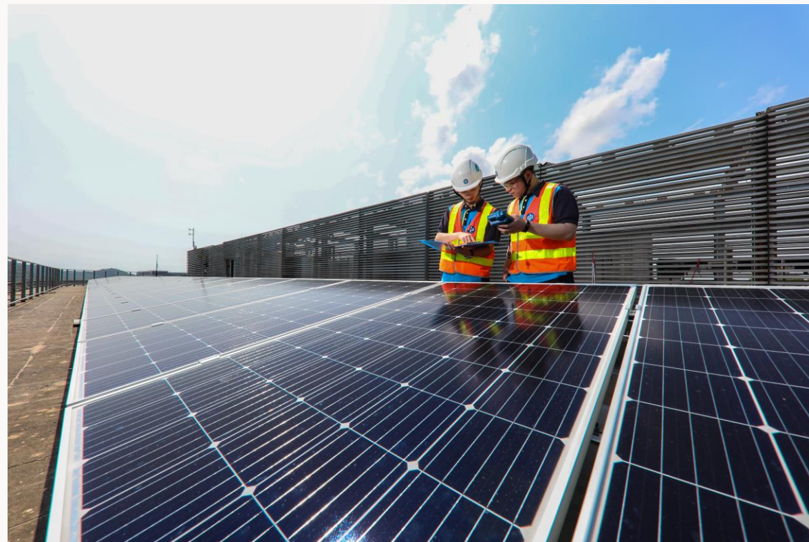
在香港国际机场安装太阳能板
