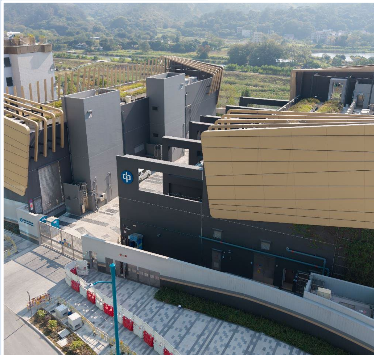
香港北部都会区的河套西变电站。
