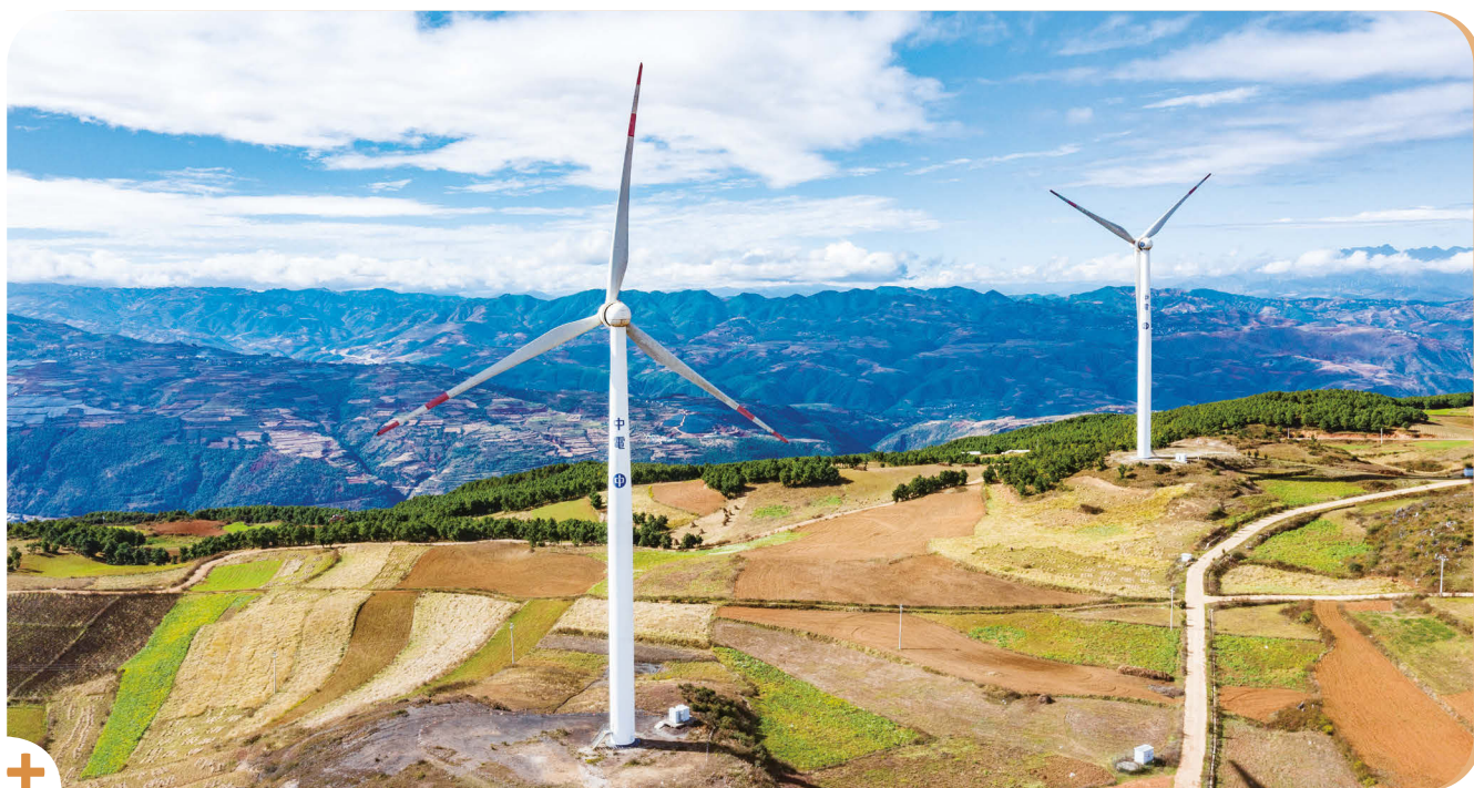
中電位於雲南省的 50 兆瓦尋甸二期風場，目標於今年下半年投產。圖為尋甸一期風場。
