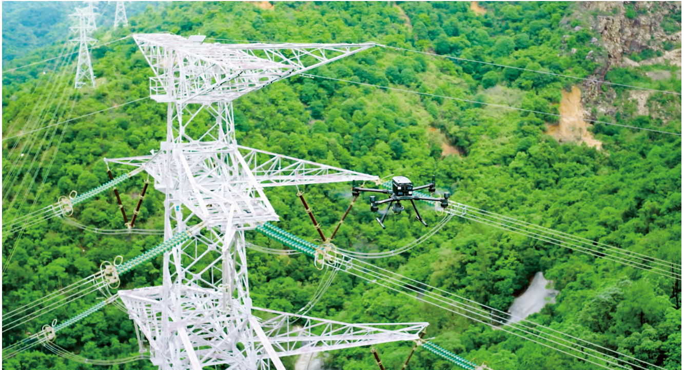
中華電力以「超視距飛行」巡查輸電塔和架空電纜，獲選為香港政府低空經濟「監管沙盒」試點項目。
