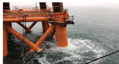
採用氣泡幕簾作為降噪措施，進一步減少興建碼頭打樁工程在海底產生的噪音
