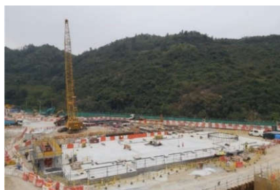
Completed HRSG foundation
