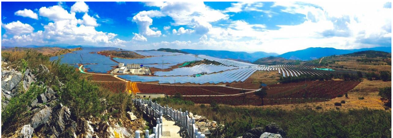
西村一期光伏電站發電容量為 50 兆瓦直流容量，佔地 86 公頃，共安裝了 204,600 塊太陽能光伏板。（按 此 觀看項目影片）
