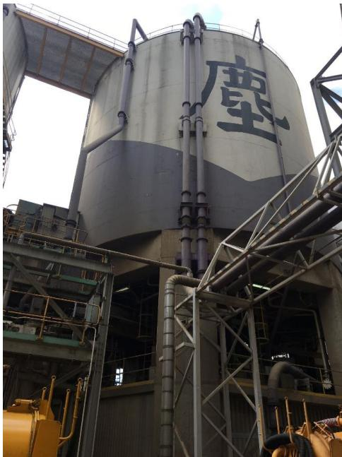
圖為青山發電廠的塵缸外貌。燃煤發電的過程中，煤被燃燒後會產生煤塵，靜電過濾後，收集入塵缸。
