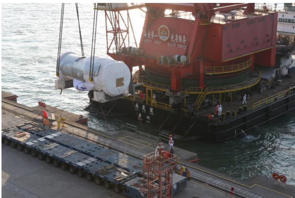
新機組的燃氣渦輪重逾 450 噸，中華電力需要從廣州打撈局租用負載重量達 900 噸的「南天龍」，在龍鼓灘發電廠對開海面進行吊運工作。
