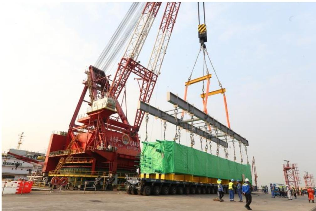
最長的部件為 15 組用於餘熱鍋爐的受熱面模塊，每組模塊長逾 30 米，相等於接近 3 部雙層巴士的長度。
