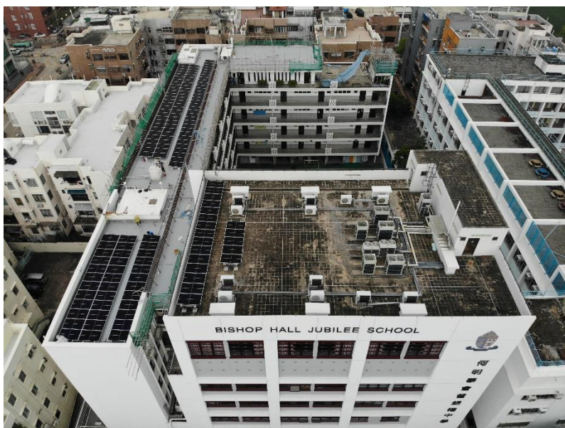
何明華會督銀禧中學於校舍內裝設 144 塊太陽能板，每年可生產近 5 萬 7 千度電。
