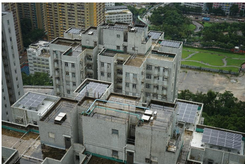
黃大仙翠竹花園的 14 幢大廈天台，已安裝了近 600 塊太陽能板，預計每年的總發電量約為 18 萬度電。
