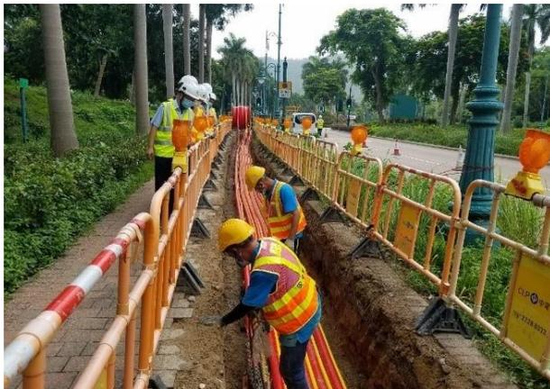
中華電力工程團隊為大嶼山竹篙灣檢疫中心鋪設地底電纜，連接電力網絡。
