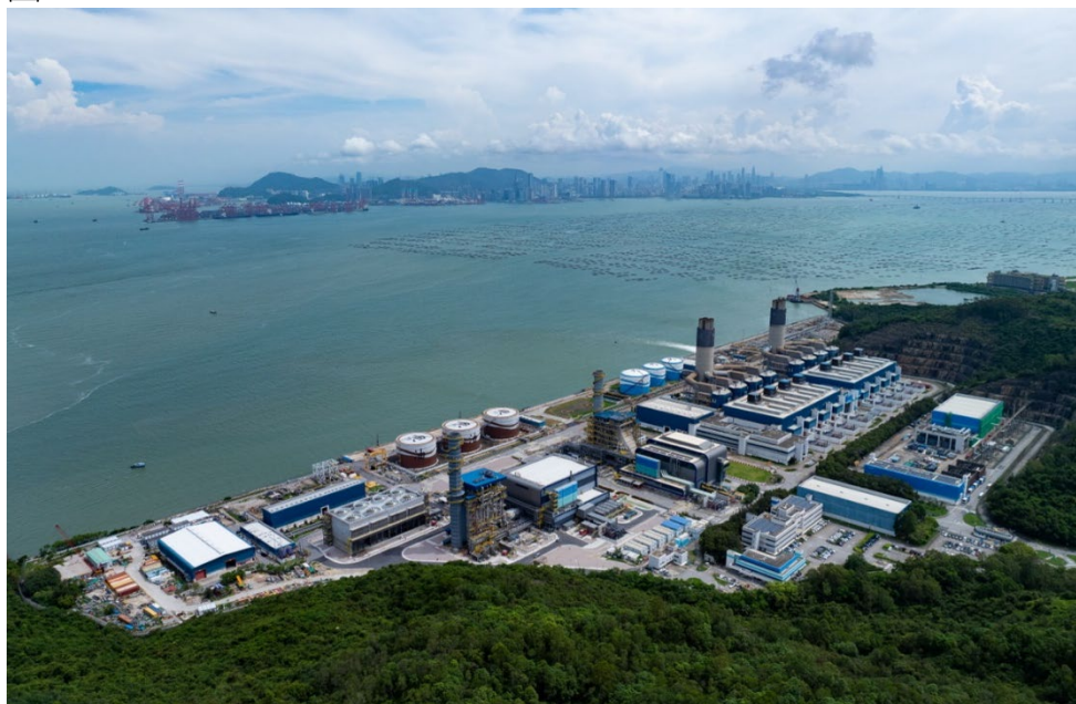
龍鼓灘發電廠於 1996 年投產，目前共有十台燃氣發電機組，發電容量達 3,850 兆瓦，是全球規模最大的聯合循環燃氣發電廠之一。
