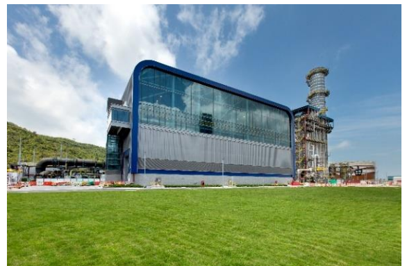
中華電力首台新燃氣發電機組於 2020 年投入運作
