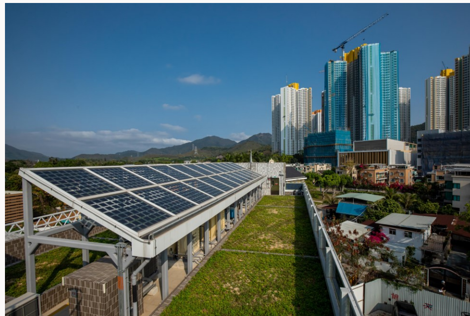
香港皇后山變電站的屋頂太陽能板
