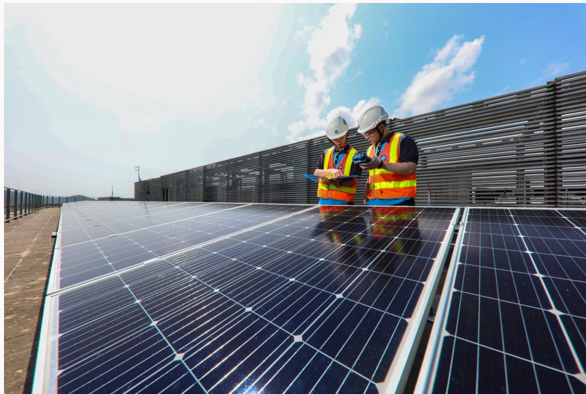
在香港國際機場安裝太陽能板
