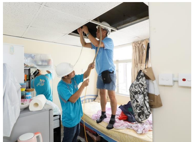
▲「全心全意」計劃協助劏房單位業主重鋪電線。
