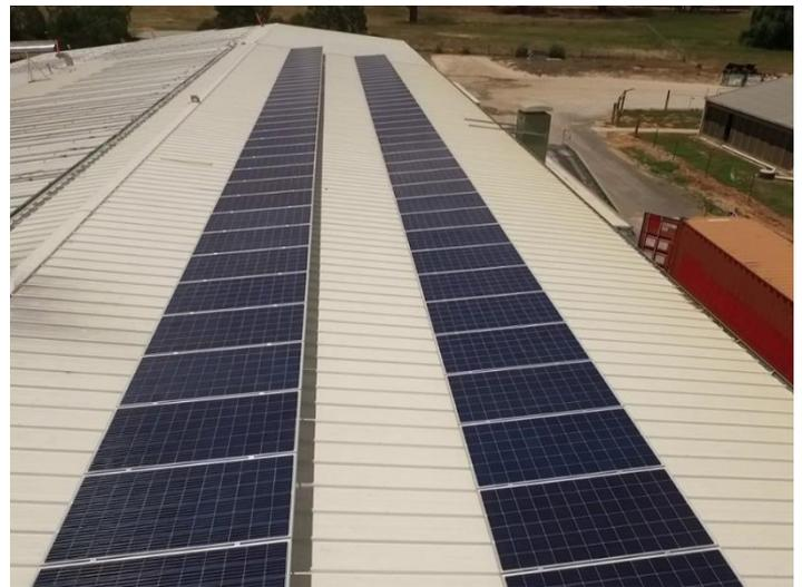
的噪音影響到雞隻生產。1 月底，在分蛋設施的廠房安裝 213 千瓦的太陽能光伏系統的工程完成，並開始供應電力。及至 8 月，農場的第二個雞棚亦轉為以太陽能發電。
