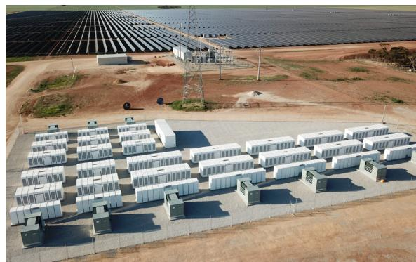
繼兩個開創先河的儲能電池項目於2018至2019年夏季投入商業運作後，EnergyAustralia成為澳洲全國電力市場零售商中擁有最大儲能電池組合的公司。Ballarat的30兆瓦/3萬度電的獨立儲能電池系統位於輸電網絡的重要地段，提供穩定的電網服務，可在需求高峰時段，為超過20,000個家庭提供一小時電力，然後在電價較低的晚間時段從電網充電。Gannawarra的25兆瓦/5萬度電的儲能電池系統是澳洲最大的綜合太陽能光伏電站，規模也是世界最大之一。
