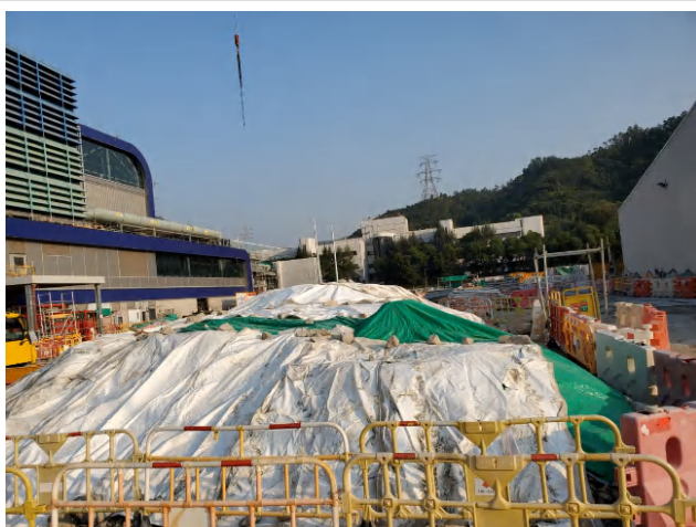
覆蓋堆存的泥料，以防止揚塵和泥面流失
