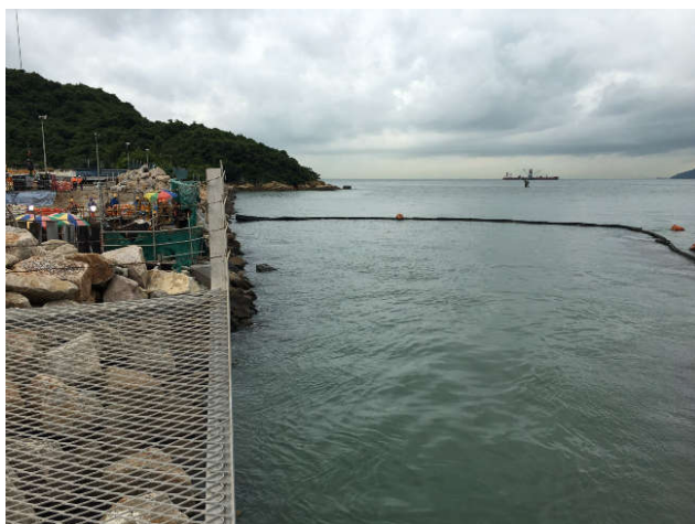
利用隔泥幕來預防和避免近海施工導至懸浮泥沙，避免影響海洋環境
